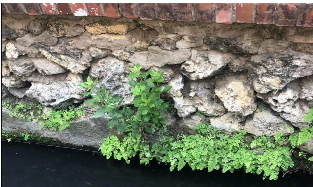
圖 5. 建興國中露明河段的咕佬石河溝壁面
